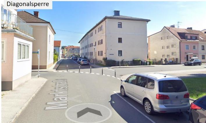
In der Marktstraße können durch eine Diagonalsperre zweispurige Kfz umgeleitet werden. Durch die Gestaltung mit Pollern ermöglicht sie dennoch Radfahrer\*innen an der Kreuzung in alle Richtungen zu fahren.
