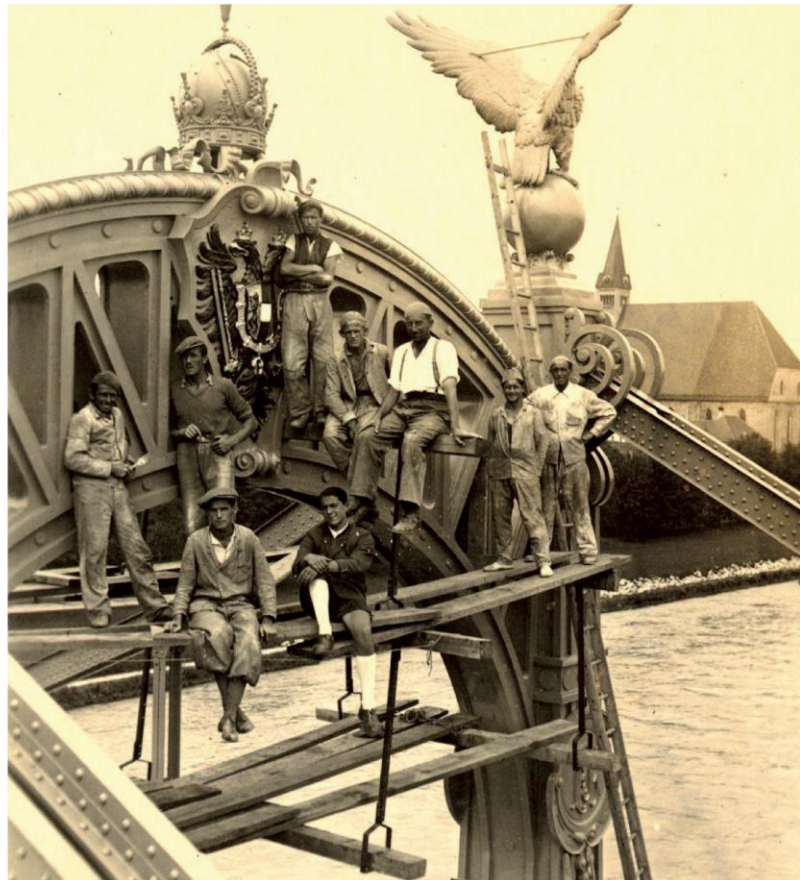
Die tollkühnen Arbeiter bei der Errichtung der Salzachbrücke.
